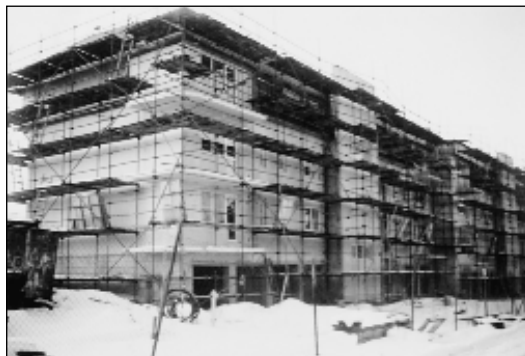
Výstavba nového domu na Zapletalově ulici.
