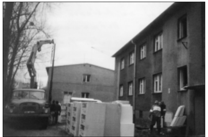
Snímek z rekonstrukce domu na Kubínově ulici v Ostravě-Heřmanicích
