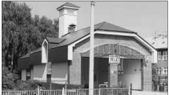
Nová hasičská zbrojnice v Antošovicích
