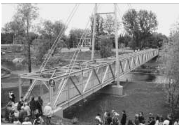
Snímky rekonstruovaného hradu a nové pěší lávky.
