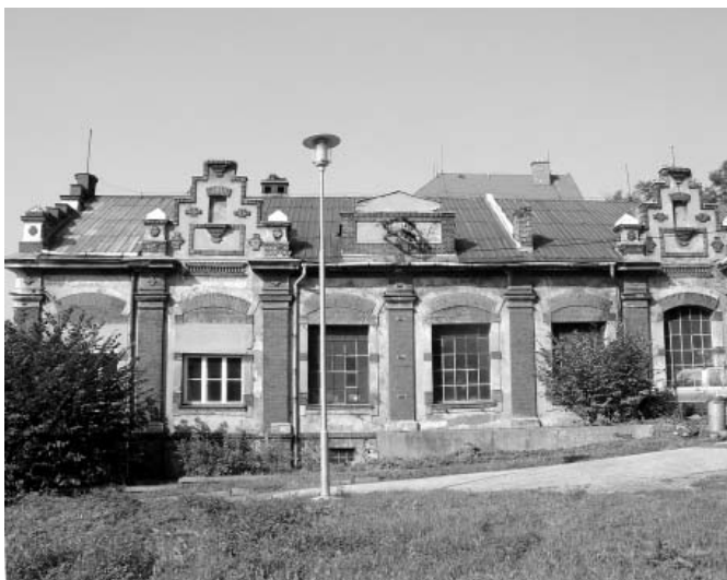
Zadní trakt býžalé elektrárny. Foto: archiv SON
