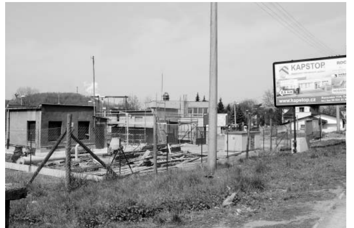
Přečerpávací stanice v Muglinově
