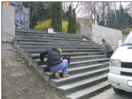
... a oprava schodiště vedoucího k tanku.
