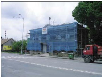
V Kunčicích byl opraven dům č. 426 na Frýdecké ulici.
