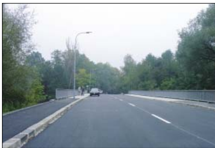
V říjnu byla zprovozněna rekonstruovaná lávka přes Lučinu.
