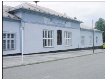
Od července do září byly prováděny opravy KD v Heřmanicích.
