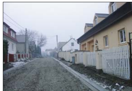
Oprava ulice Pod Lanovkou v Muglinově.
