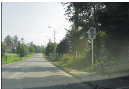
Výstavba chodníku podél Antošovické ulice v Antošovcích.
