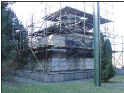
Rekonstrukce kulturní památky – tanku 1. čs. samostatné brigády...
