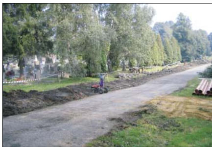
Z účelové státní dotace byly opraveny chodníky na Ústředním hřbitově.
