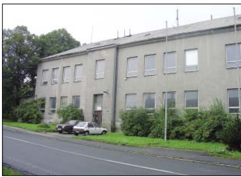
Foto objektu: archiv SON
