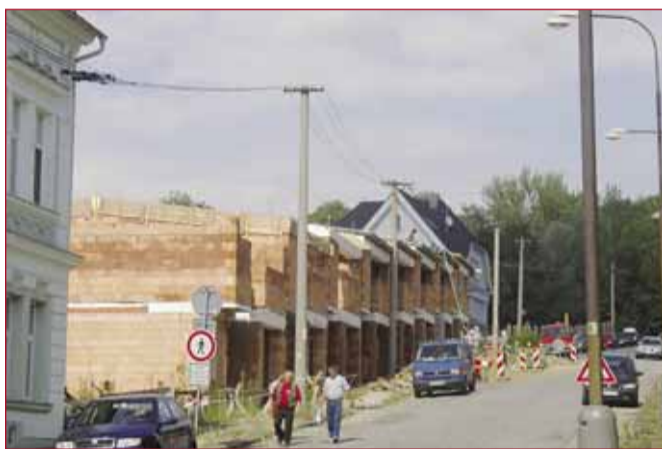
Výstavba u Keltičkovy ulice
