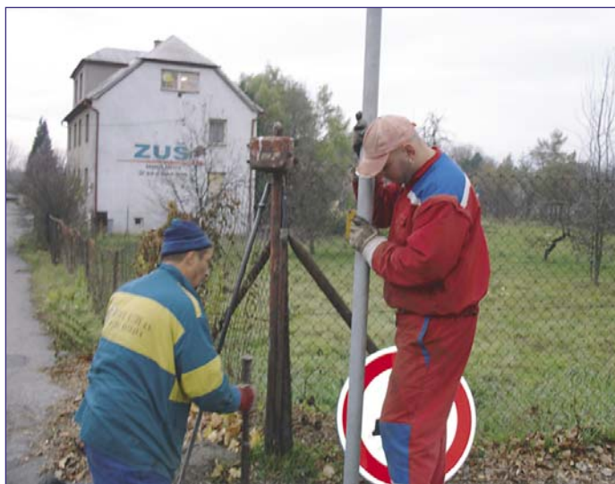
Foto z instalování nové značky v Muglinově: archiv SON
