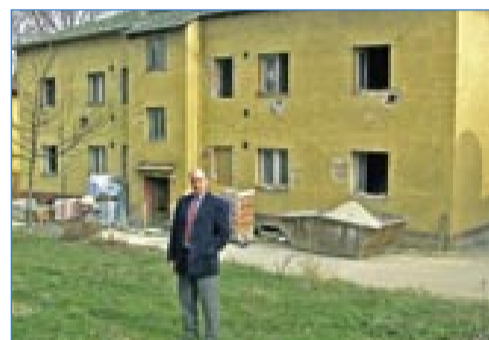
Pan místostarosta Petr Zezulčík před domem v Nové osadě, kde probíhá rekonstrukce bytů.
