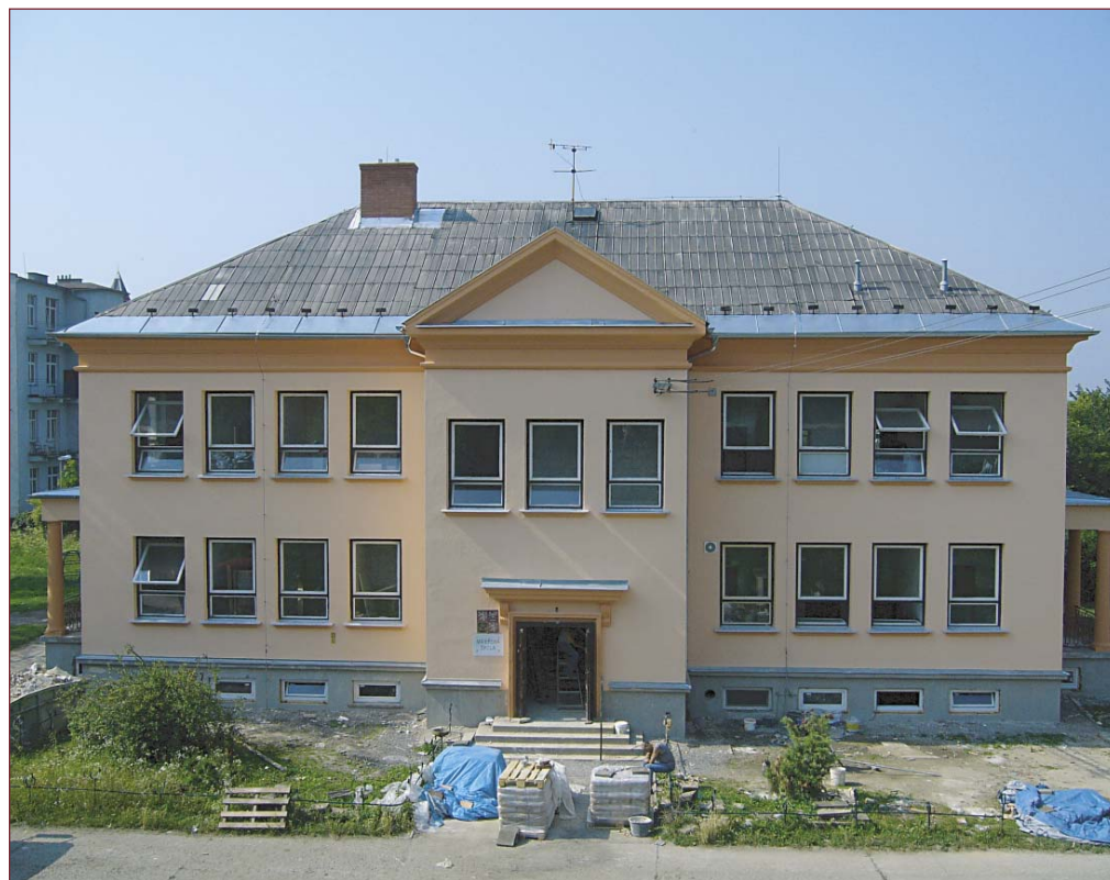
Rekonstrukce MŠ na Zámostní ulici
