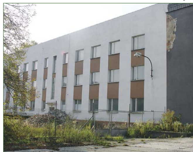
Foto jedné z budov budoucích kolejí před rekonstrukcí.
