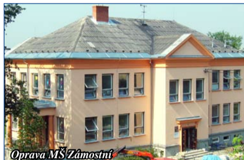
Oprava MŠ Záměstní
