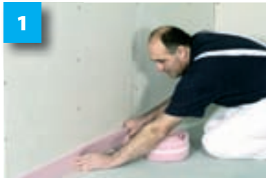
Připevnění okrajových pásek
