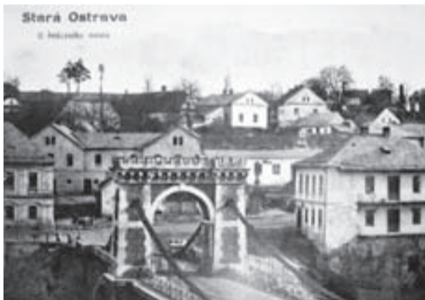
Řetězový most přes Ostravicí (na místě dnešního Sýkorova mostu), který sloužil mezi lety 1851 - 1886. Nakonec se zřítíl pod pochodovým krokem oddílu rakousko-uherské armády 15. 9. 1886 a byl nahrazen v 90. letech 19. století dnešním mostem.
