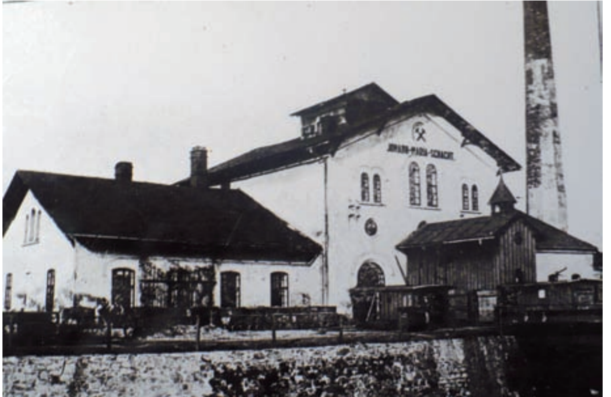
Pohled z roku 1900 na Jan Mariu před rekonstrukcí, která se uskutečnila v roce 1904, kdy byla postavena nová těžní věž.
