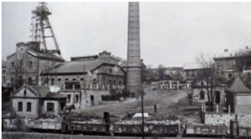
Pohled na těžní jámu od dnešní tramvajové smyčky na Hranečnicku z roku 1928.
