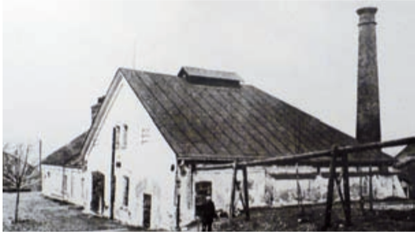
Výdušná jáma, která byla postavena asi 200 metrů západně od těžní jámy v blízkosti křižovatky ulic Těšínské a Zvěřínské. Dnes je na tomto místě výdejna uhlí a koks.
