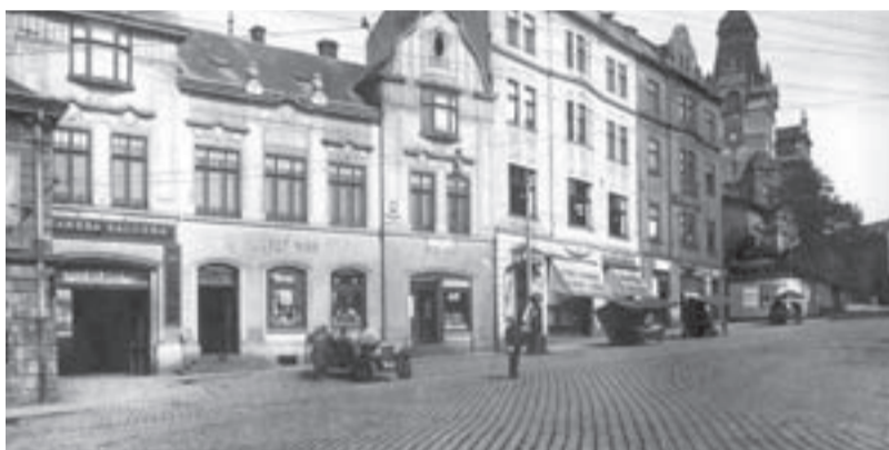
Pohled na radnici a přilehlé domy, které stály proti Sýkorovu mostu z roku 1935. Naprostá většina domů byla zbourána při výstavbě nové čtyřproudové komunikace Bohumínská okolo roku 1970.
