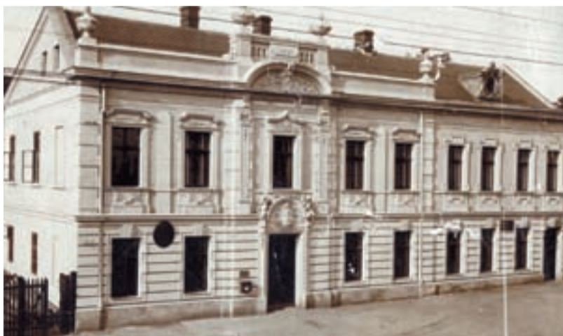
Budova staré radnice (z roku 1900), která stála v místě mezi nynější slezskoostravskou radnicí a autosalonem Opel.
