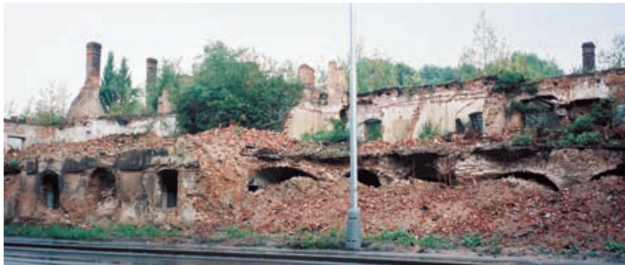
Stav z roku 2003 - pohled na zbořeniště od Frýdecké ulice.
