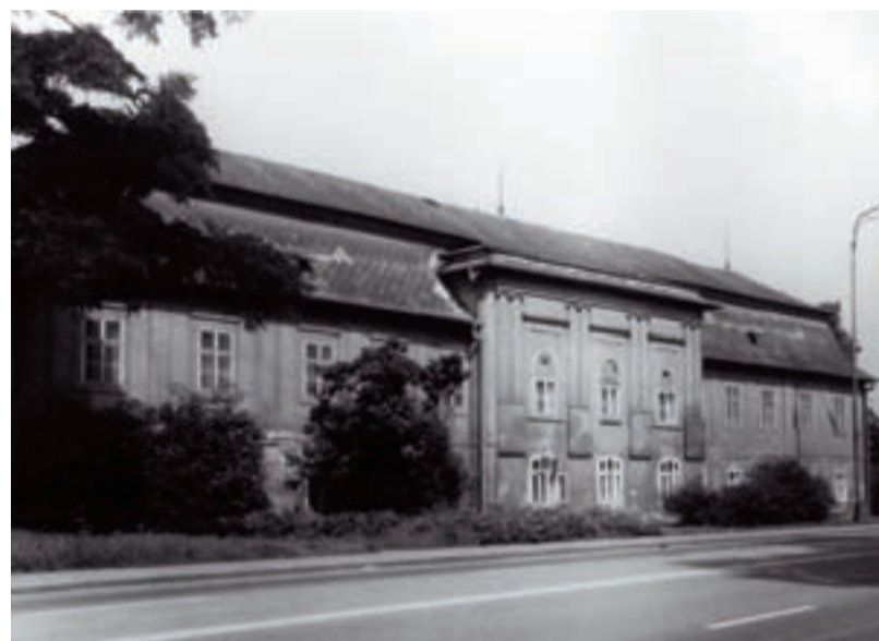
Pohled na východní křídlo.
