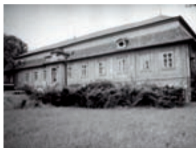
Pohled na jižní křídlo.
