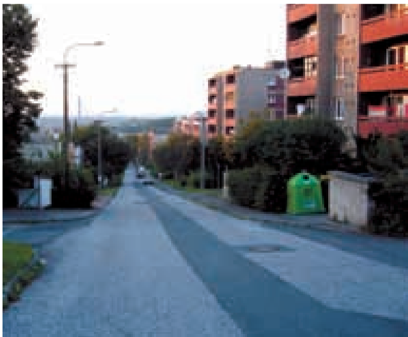
DO GALA. Cílem projektu regenerace sídlíště v Muglinově, které čítá zhruba 580 bytů v panelových domech, je zlepšení životních podmínek zdejších obyvatel.
