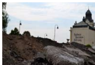
TĚŠÍNSKÁ. U slezskoostrovské radnice vzniklo veliké staveniště. FOTO/JAN KRÁL
