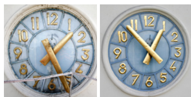
OPRAVA. Ciferníky slezskostravské radnice před opravou a po opravě. FOTO/ARCHIV
