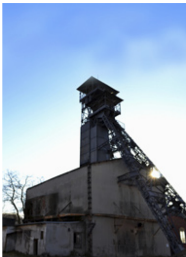
PŘED OPRAVOU. Poslední ze tří budov má být opravena letos.
