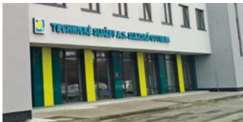
REKONSTRUKCE. Proměna budovy TS. Foto/ archiv
