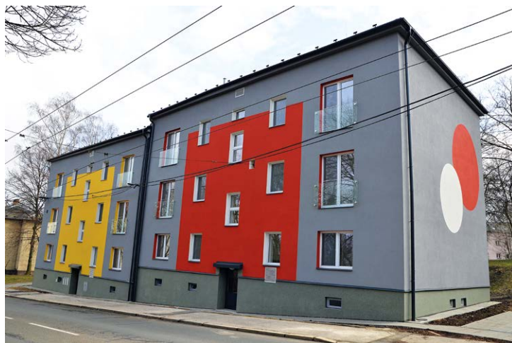
PŘED DOKONČENÍM. Komunitní dům pro seniory, Heřmanická ulice. Foto/ Jan Král
