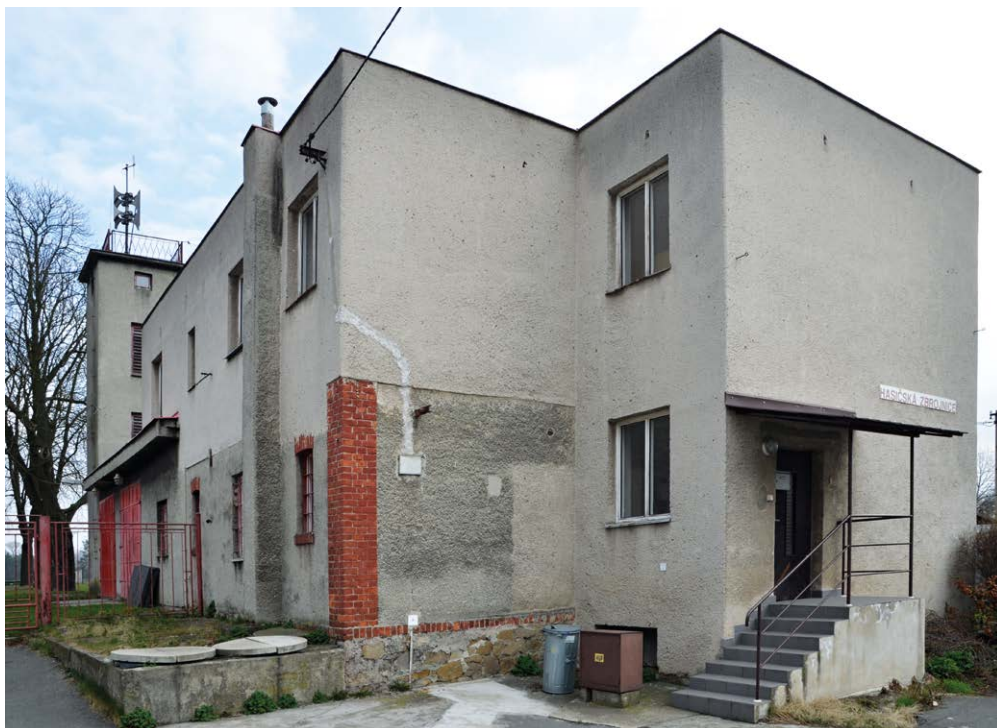
PŘED REKONSTRUKCÍ. Hasičská zbrojnice Koblov. Foto/ Jan Král
