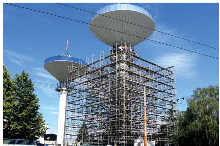
REKONSTRUKCE. Vodojem na Hladnově zakrylo lešení. Foto/ Lubomír Časnocha
