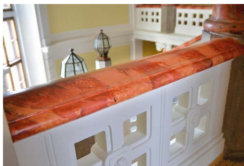
OPRAVENO. Madla zábradlí před opravou a po ní. Foto/ JK
