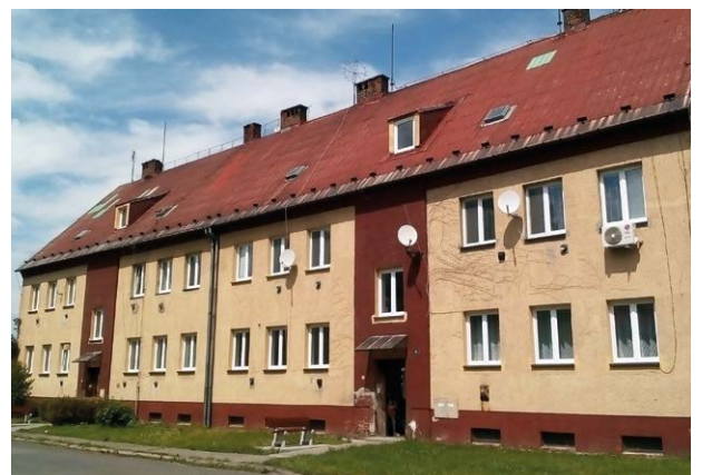
Výměna oken na ulici 8. března 14 a 16
