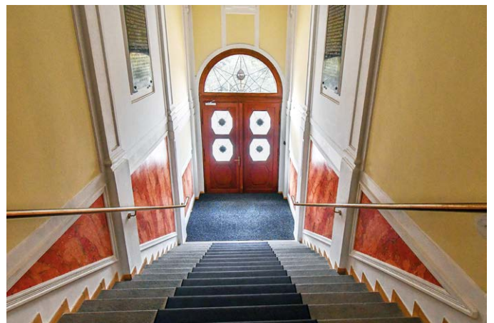
Rekonstrukce zábradlí, bočních štuk i vchodových dveří
