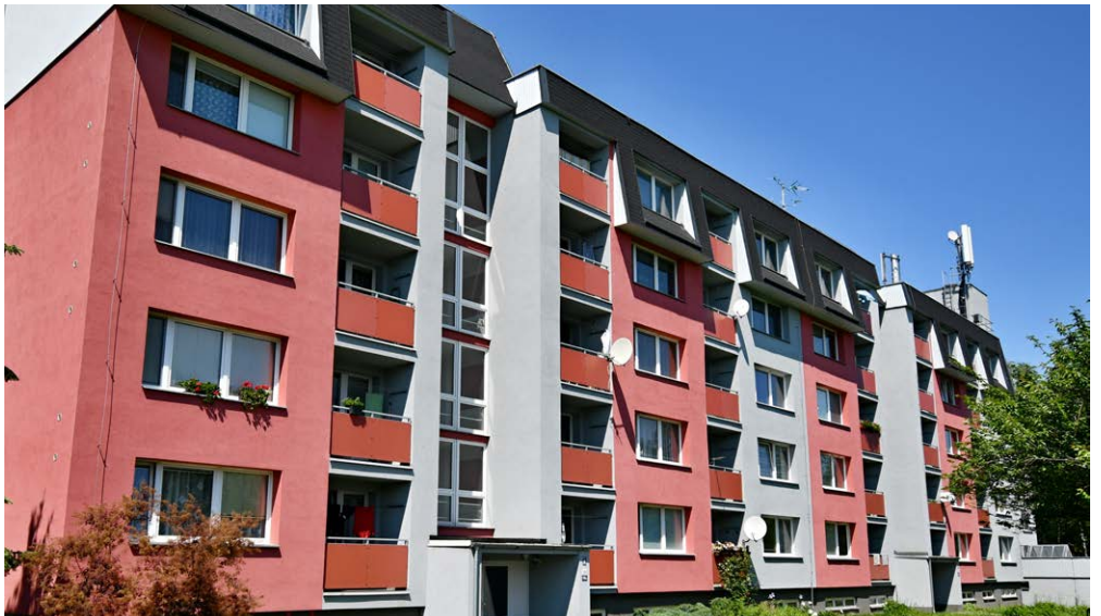
DPS HLADNOVSKÁ. Opravené bydlení pro seniory v Muglinově. Foto/ JK
