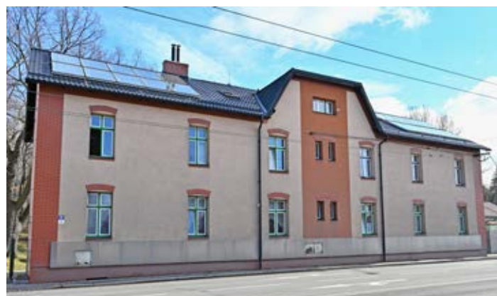
Vstupní byty, Bohumínská 25, Muglinov
