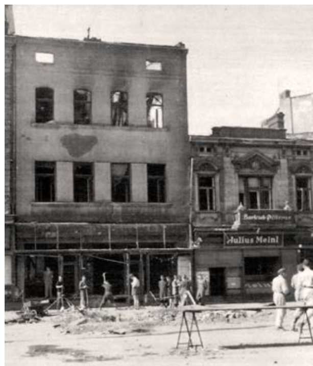
Po bombardování vyhořelá drogerie Malík (vlevo) stávala na jihozápadní, dnes už neexistující straně náměstí.
