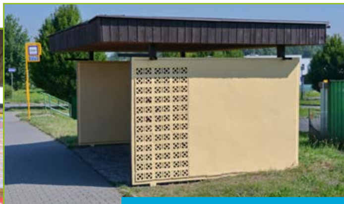
Opravená zastávka Sídliště Muglinov na Hladnovské ulici.
