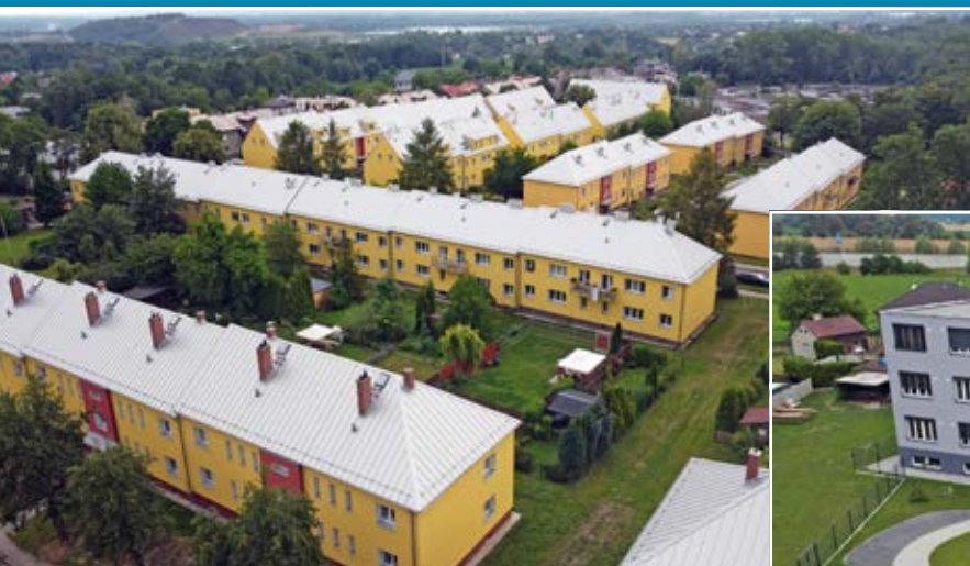
Celkem 38 domů opraveno na Mírové Osadě.
