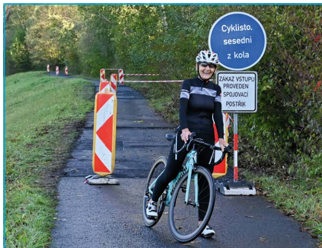
Během měsíce října byla opravována cyklostezka v blízkosti nové lávky spojující Slezskou Ostravu s Dolní oblastí Vítkovic.
