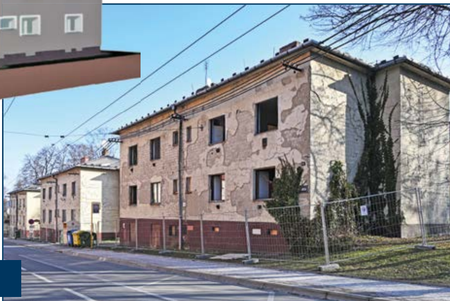
Zdevastované domy na Heřmanické ulici procházejí kompletní rekonstrukcí.
