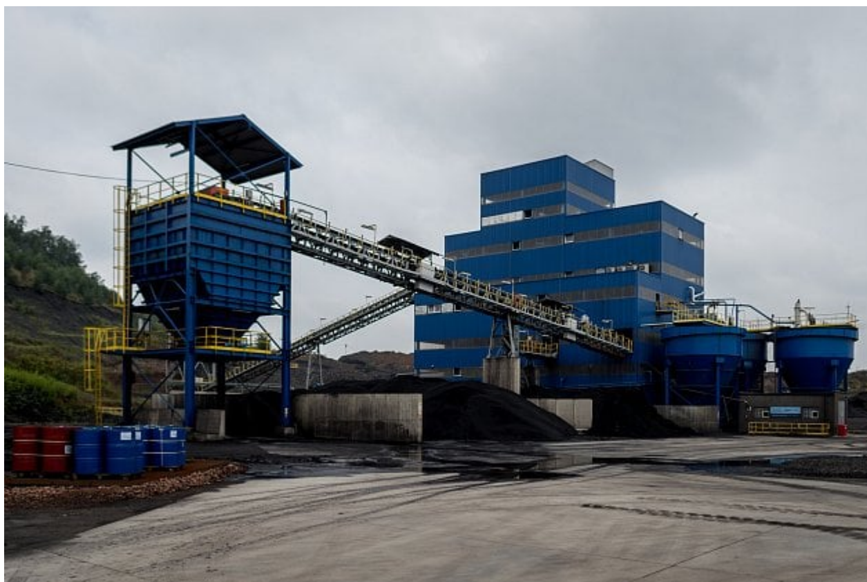
Obrázek 1 Třídící linka pro homogenizaci hlušiny
